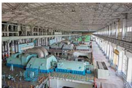
В главном корпусе станции установлены десять блоков. Восемь из них работают на угольной пыли, а два — на мазуте
