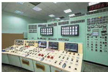
На пульте управления девятым блоком установлена современная система контроля и отображения информации
